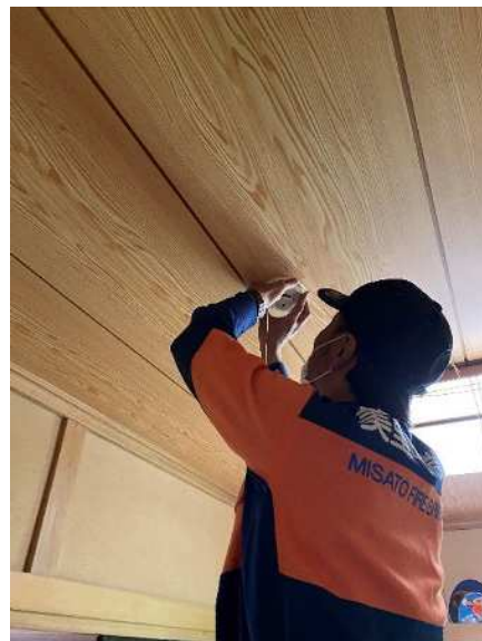
消防団による取付けの様子
